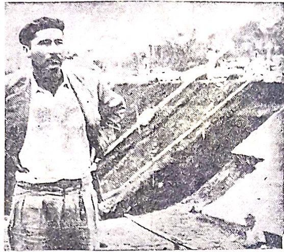
ESTE ES JUAN DIAZ, capataz de la obra Canal del Oeste, que realiza el Gobierno de la Provincia, colaborando con el Segundo Plan Quinquenal.
