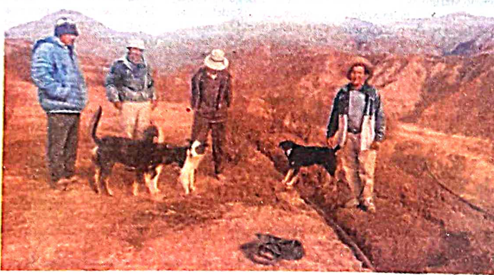
Vecinos reparan la red de agua que hicieron por cuenta propia.
